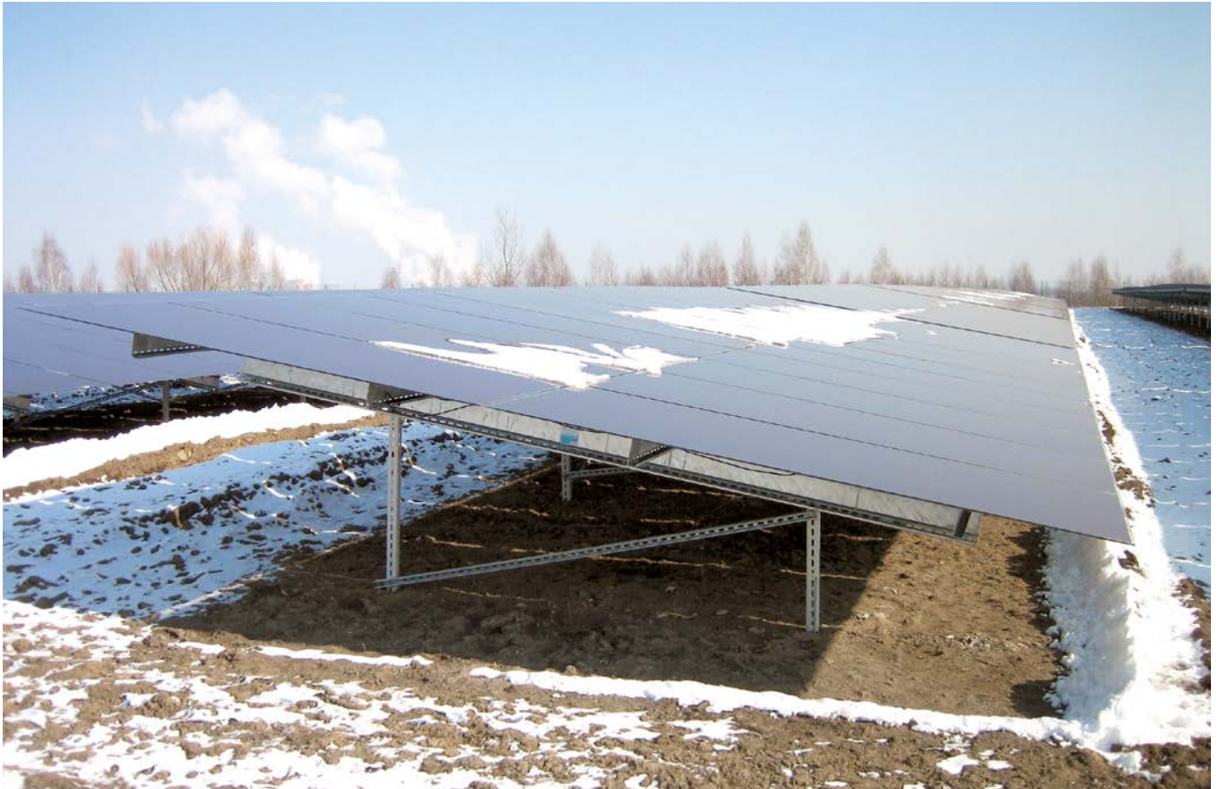
Module, Dünnschicht mit Back Rails, 2,6 x 1,1 m, 2-reihig, vertikal Modules, thin-film with back rails, 2.6 x 1.1 m, 2-rows, portrait
