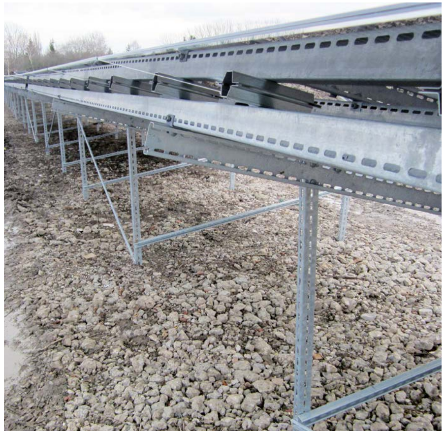
Module, Dünnschicht mit Back Rails, 1,3 x 1,1 m, 3-reihig, vertikal Modules, thin-film with back rails, 1.3 x 1.1 m, 3-rows, portrait
