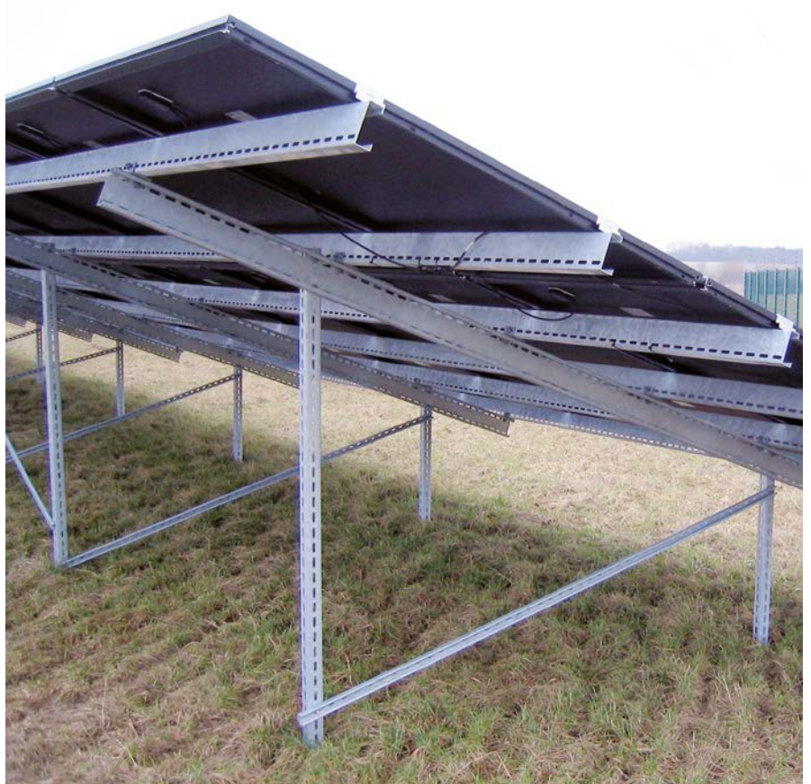
Module, Dünnschicht, gerahmt, 3-reihig, vertikal Modules, thin-film, framed, 3-rows, portrait
